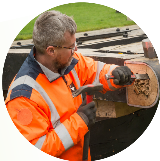
Atelier de fabrication des portes d'écluses en bois
